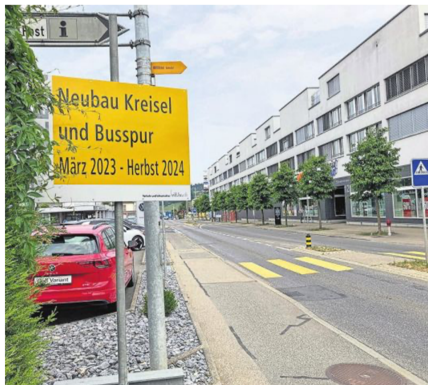
Diese Tafel beim Chrüzhof zeigt es an: Die Bauarbeiten rund um die Grundmatt werden (nicht nur) Verkehrsteilnehmende länger beschäftigen. Foto Ramon Juchli
